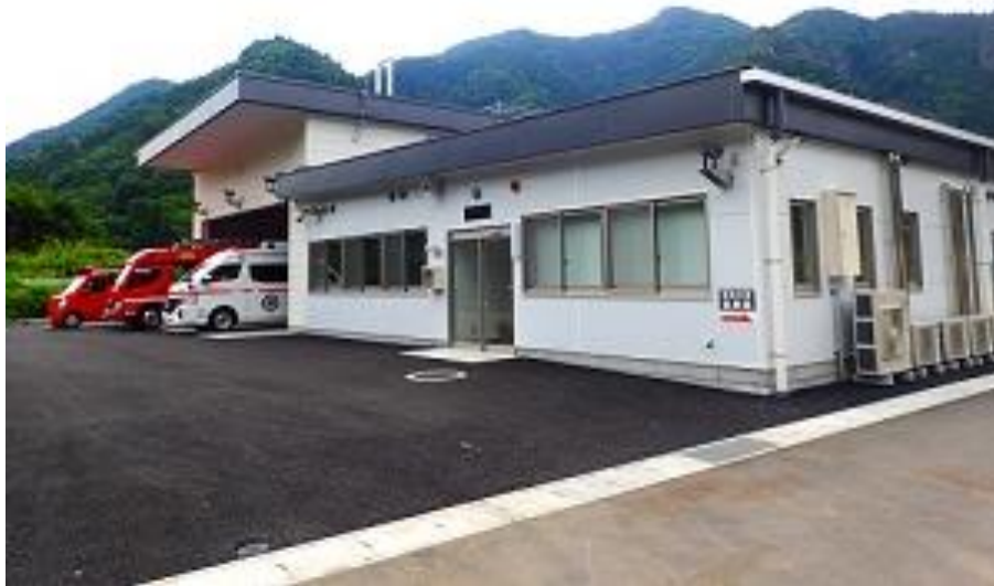
庁舎及び配備車両（令和6年10月1日現在）
